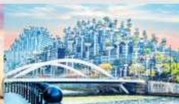
อาคารฟันทันไม
